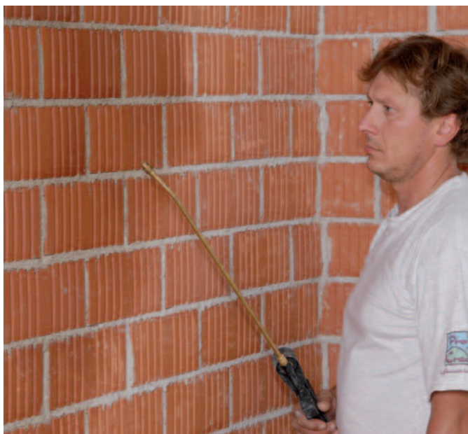
Zvlhčení zdiva penetračním roztokem jako ochrana proti praskání spár čerstvého zdiva.
