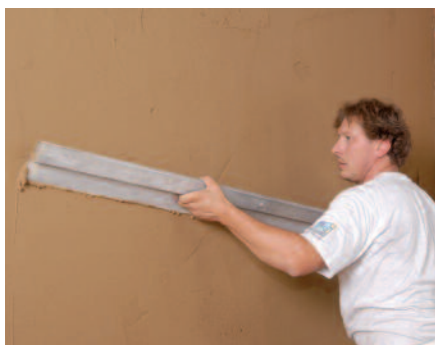
Natažení pomocí stírací lišty.
