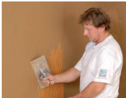
Pomocí kletovacího hladítka zatlačte tkaninu do omítky.
