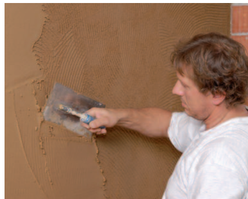
Uhlazení povrchu pro pozdější nanesení lícni omítky.
