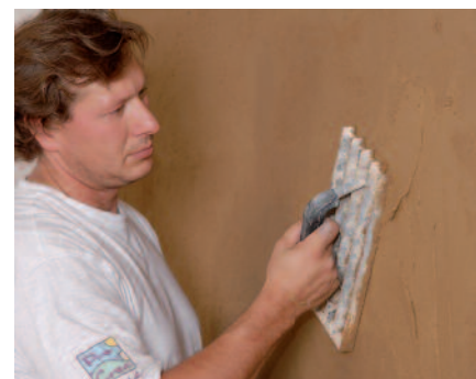
Dorovnání pomocí hladítka s mřížkou, pokud je to nutné.
