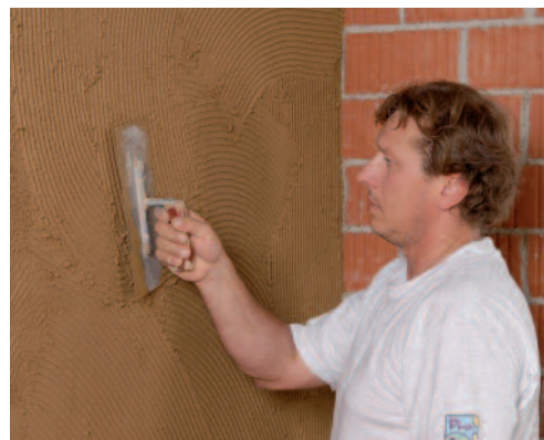
Nanesení jádrové omítky pomocí ozubeného hladítka.
