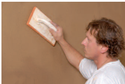
Plstění ProCrea® hliněné lícní omítky pomocí hrubého houbového hladítka.
