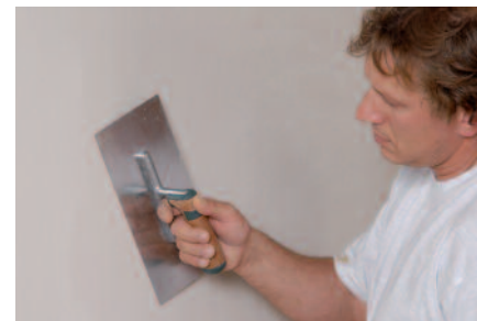
Vyhlazení dekorativní omítky kletovacím hladítkem vytvoří velmi hladký povrch.
