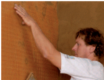
Vyztužovací tkaninu vložte do čerstvé omítky.
